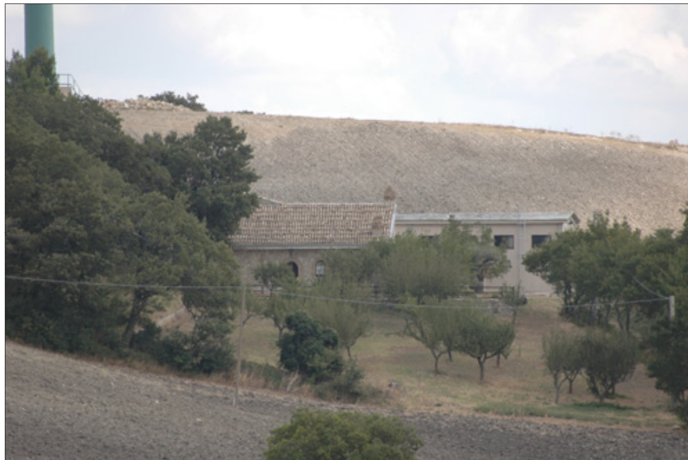
Foto 1 - Vista da ovest
