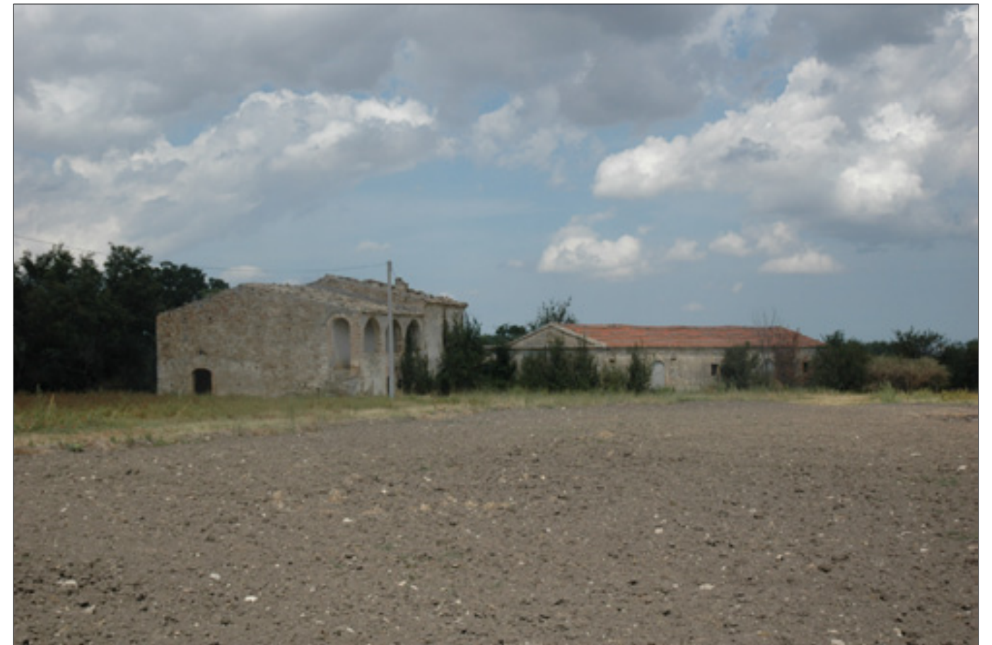
Foto 1 - Vista da sud
