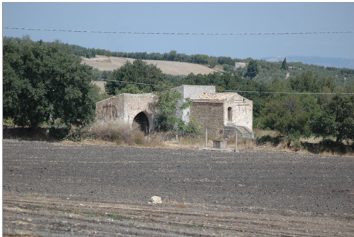
Foto 1 - Vista da sud
