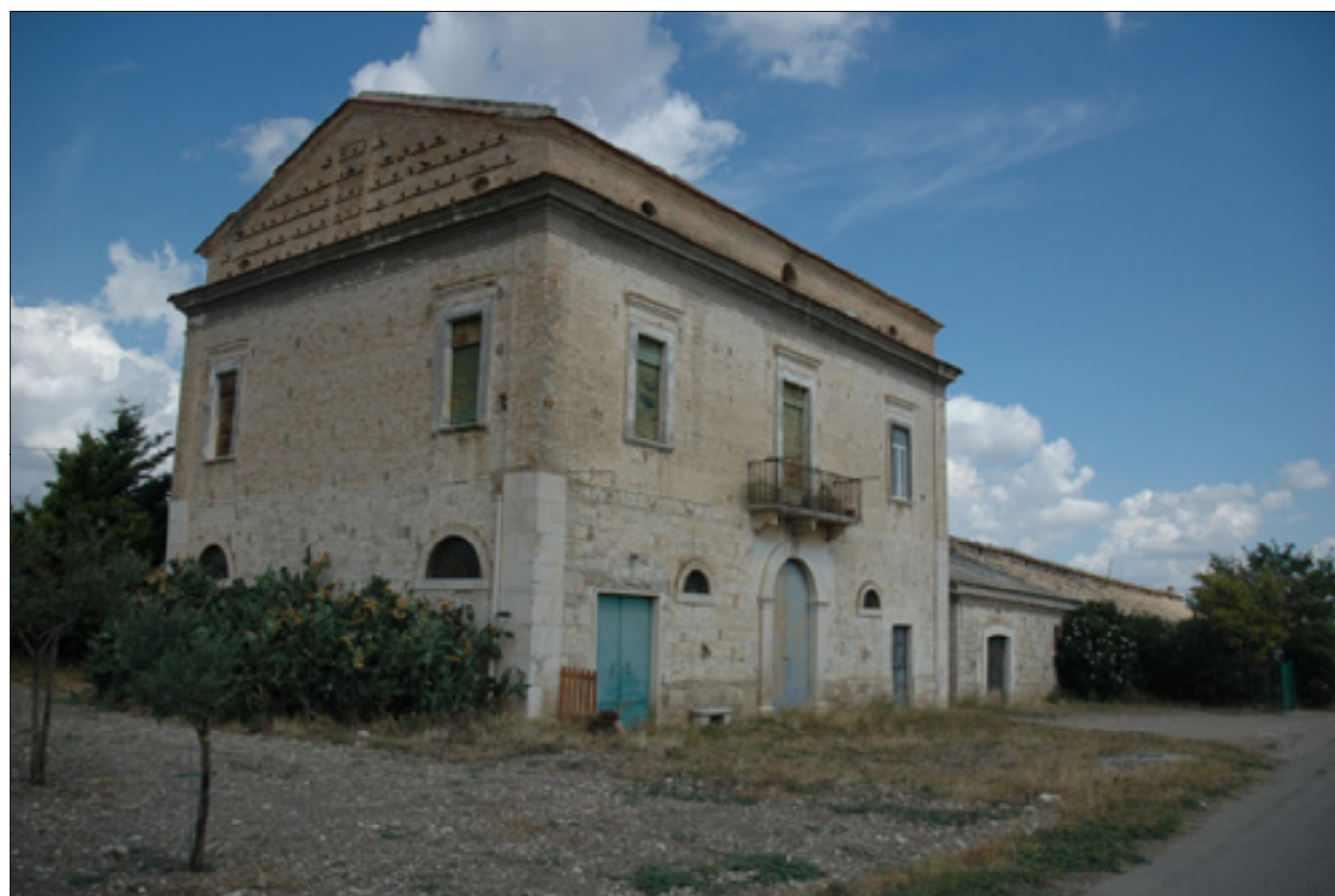
Foto 2 - Vista da sud dei fabbricati
