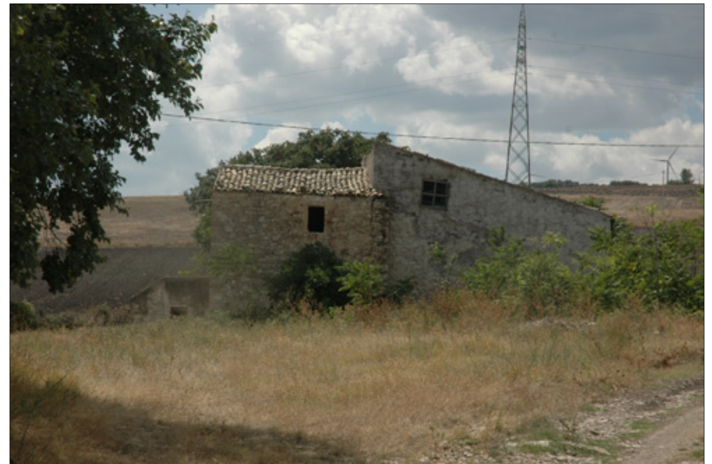
Foto 2 - Vista dalla strada
