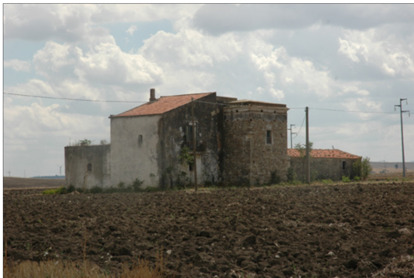
Foto 1 - Vista da nord
