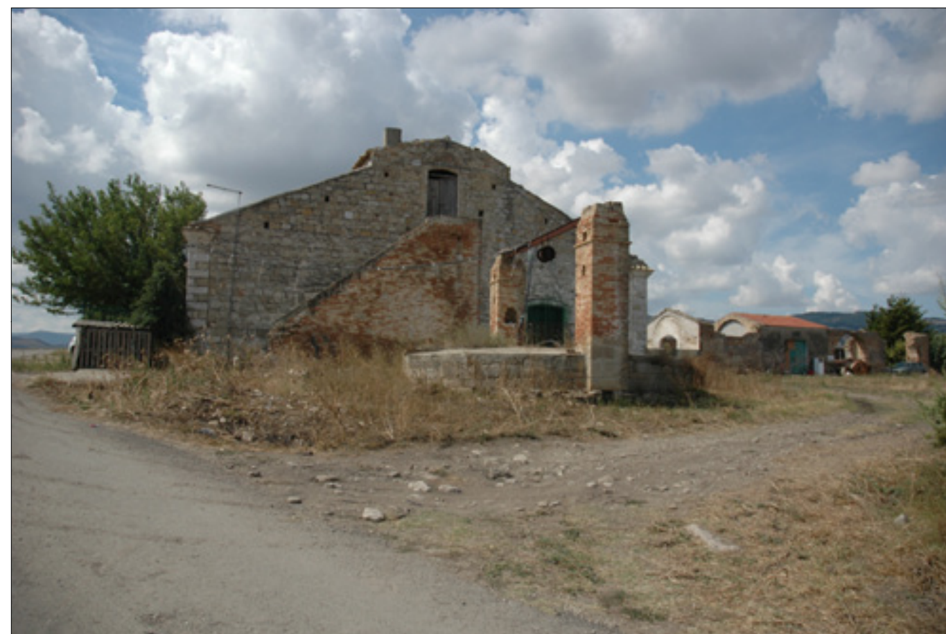
Foto 3 - Vista da nord dei fabbricati
