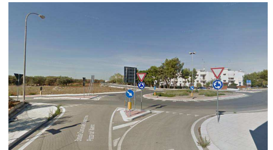
Figura 17: Rotatoria di recente realizzazione sulla viabilità in accesso a Capurso
