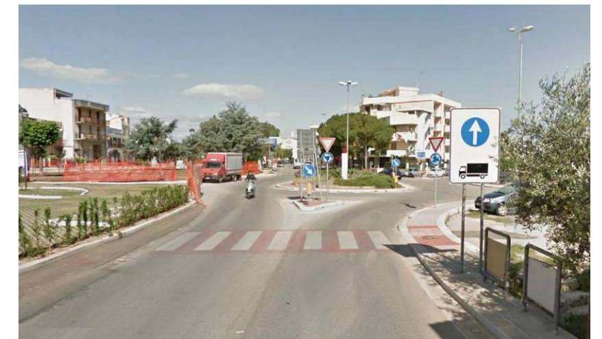
Figura 16: Rotatoria di recente realizzazione sulla viabilità in accesso a Capurso
