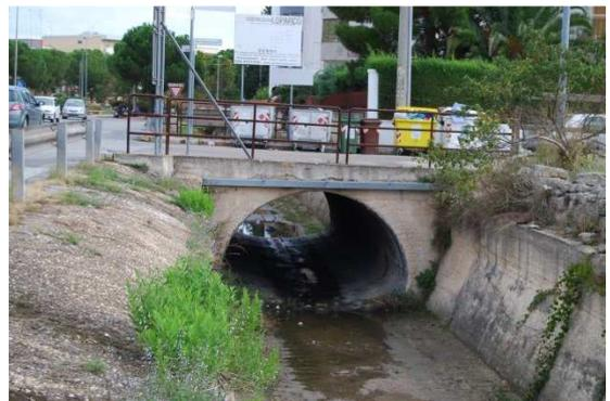
Al fine di eliminare l'insufficienza idraulica descritta si rende necessaria la realizzazione di un nuovo attraversamento con sezione rettangolare minima di 3.80 m x 2.60 m (H) che riesce a far transitare la piena garantendo un franco di sicurezza di 1.00 m.
